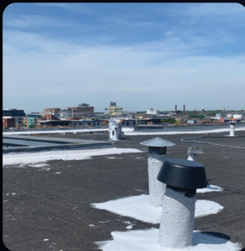
VENTILACIONES Y TUBERÍAS
